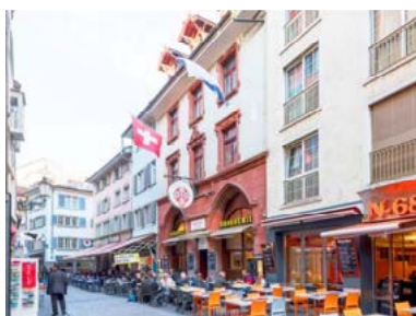
Zürich, Niederdorfstrasse 70, Zähringerstrasse 33
